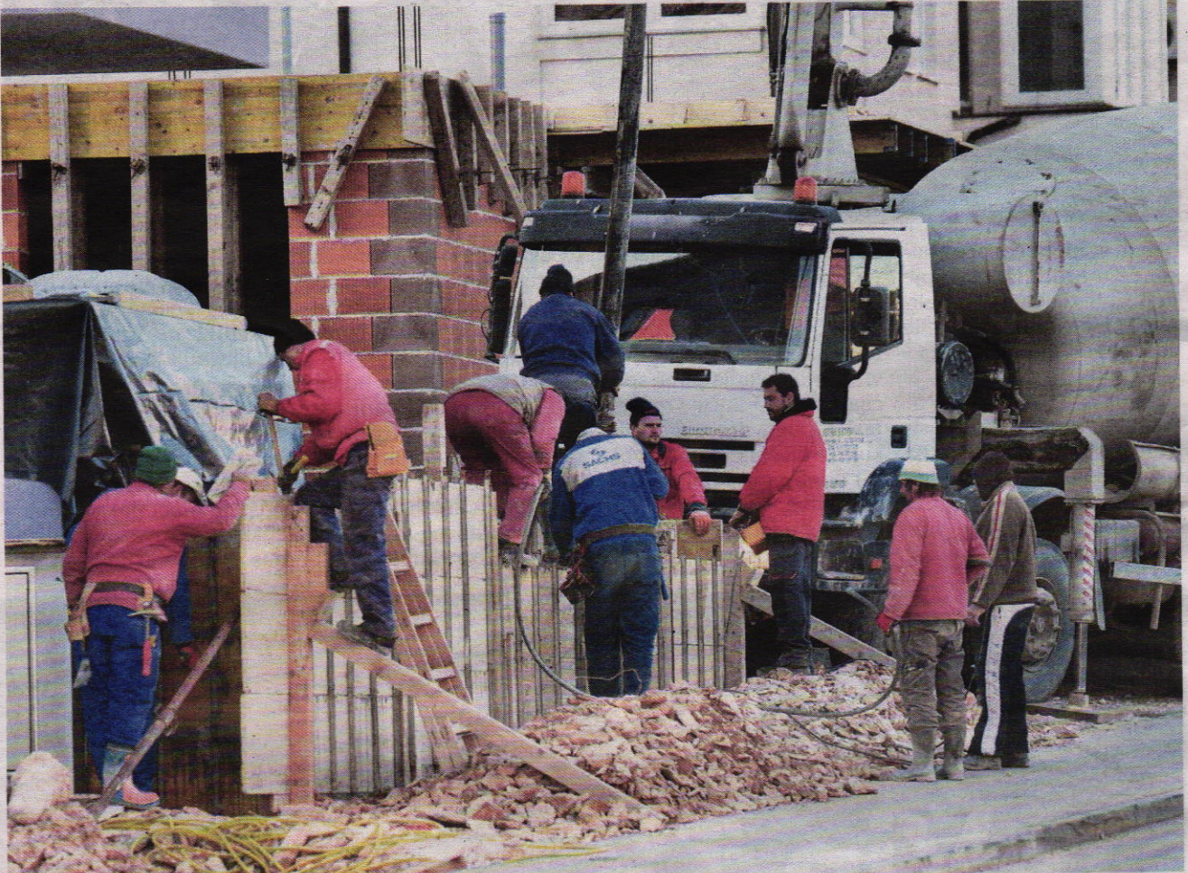
Polaznici će učiti o izolacijskim materijalima, pravilnoj ugradnji izolacije i vanjske stolarije...
