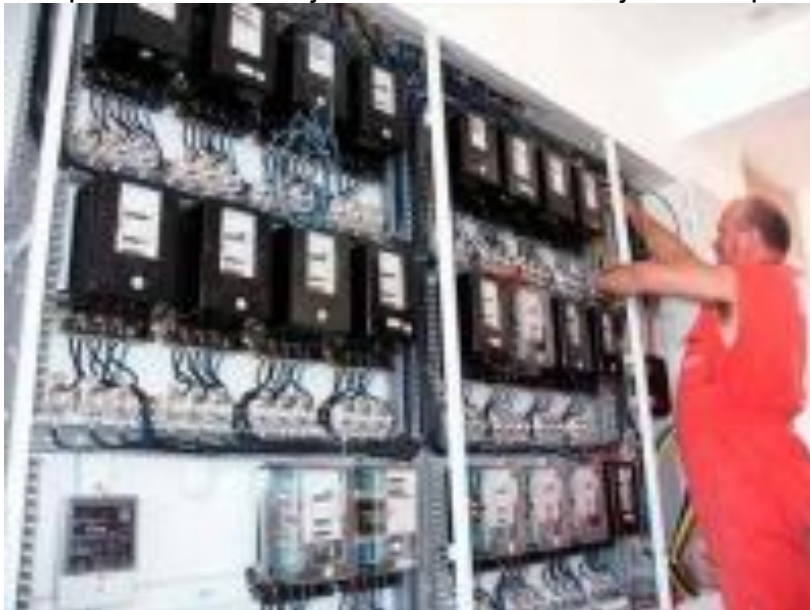
Radovi na mjernom ormaru
